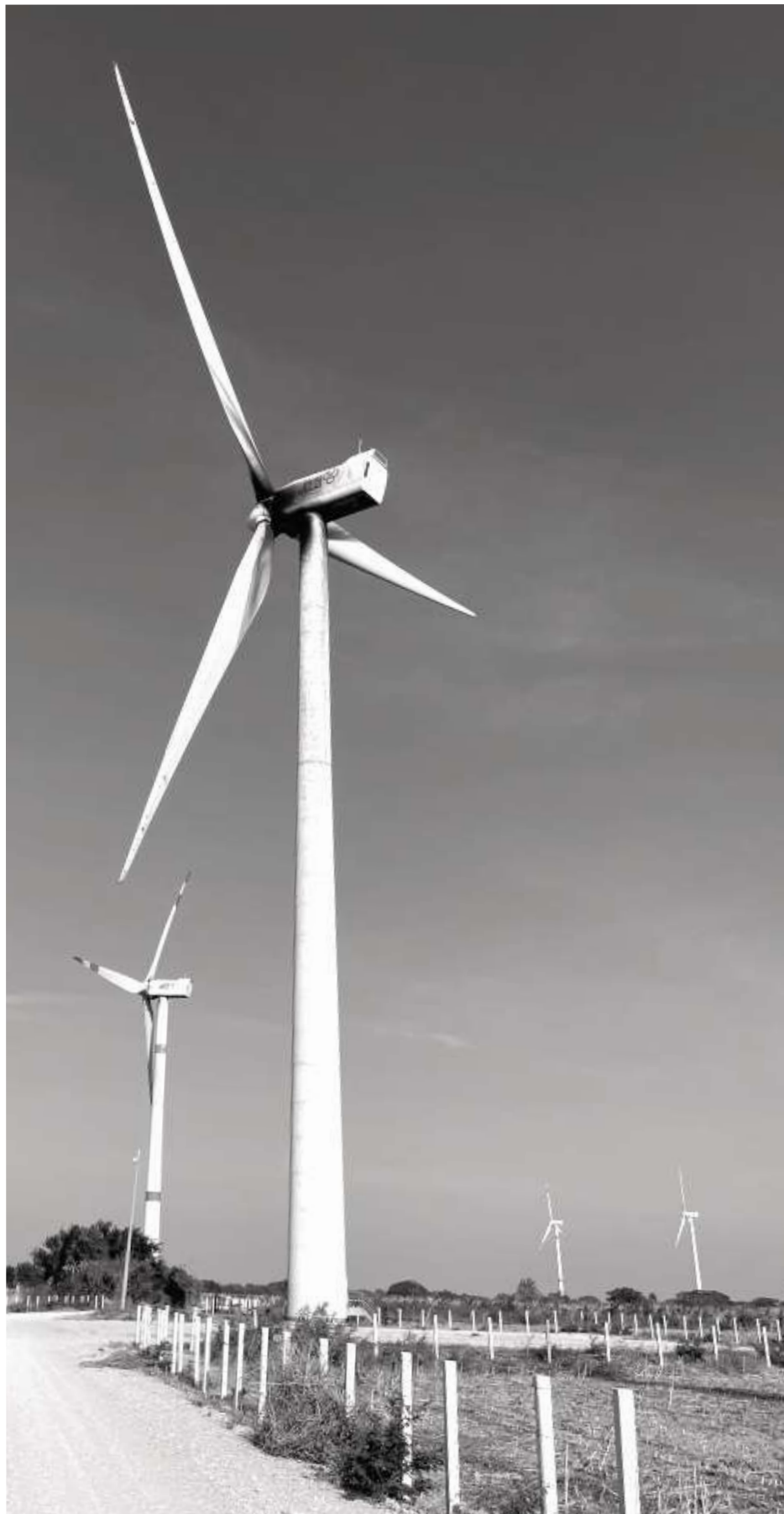
Windparks in Oaxaca, Mexiko: Viele der Windturbinen sind schlecht gewartet und verlieren Öl, das auf die Felder und Weiden tropft und auch ins Grundwasser gelangt.
